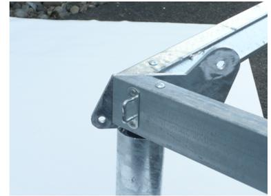
Befestigung der Seitentraverse mit Schrauben, ohne Gegengewinde
